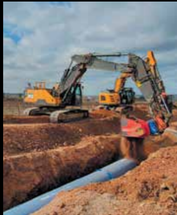
ÅTERFYLLNING RÖRGRAV
